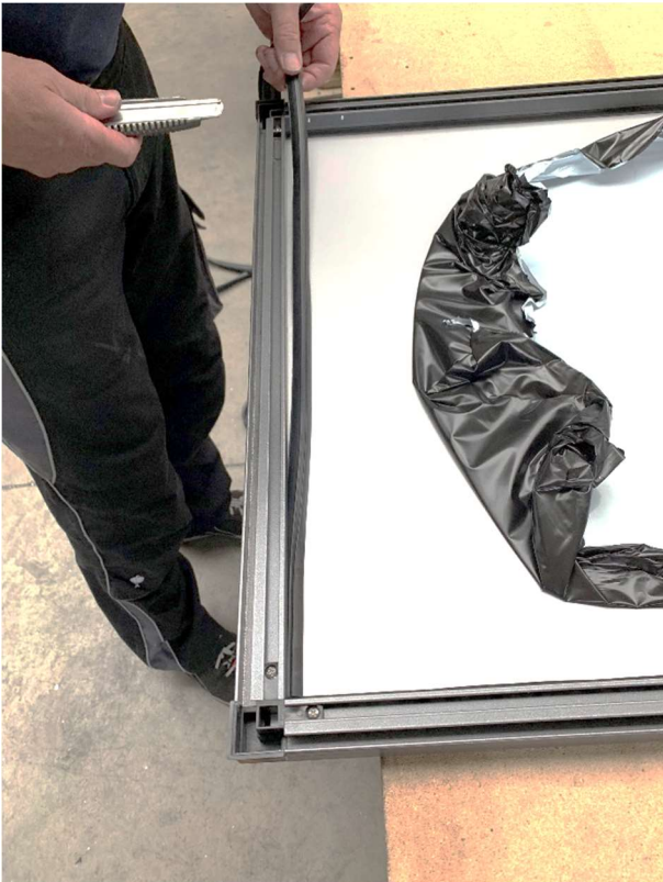
3. Kürzen Sie die Dichtung, sodass diese etwas länger ist (ca. 2 %) / Hinweis: Dichtung zieht sich zusammen
